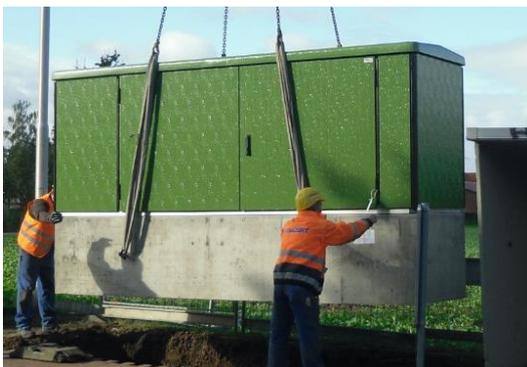
Für Anschlüsse größer  $Q_n = 10\text{m}^3/\text{h}$  DN50 bietet sich, sofern die Anschlusseinrichtung nach DIN 18012 nicht möglich ist, ein Wasserzählerschrank an.
